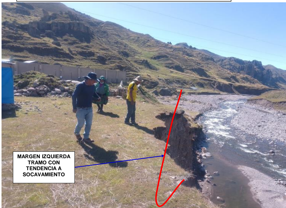
FIGURA N° 03: RIO HUARAJO EN LA TEMPORADA DE MAXIMAS AVENIDAS AFECTA CON SOCAVAMIENTO POR LA MARGEN IZQUIERDA A LA ALTURA DE LOZA DEPORTIVA. ALHUACCHUYO
